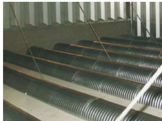
Rundbuekanaler udlagt på gulv
